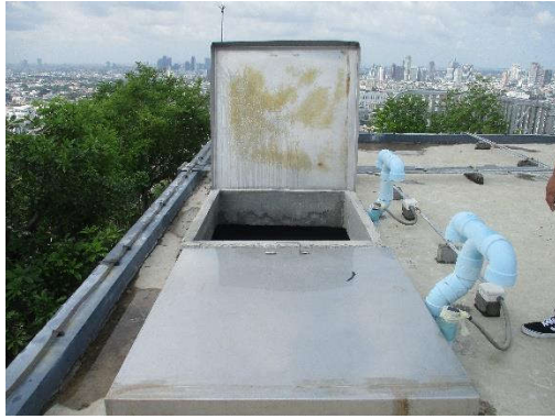
รูปที่ 13 ถังสำรองน้ำใช้ (ชั้นดาดฟ้าและชั้นใต้ดิน)
