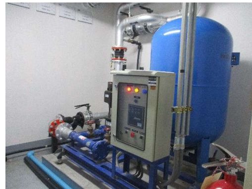
รูปที่ 13 ถังสำรองน้ำใช้ (ชั้นดาดฟ้าและชั้นใต้ดิน)
