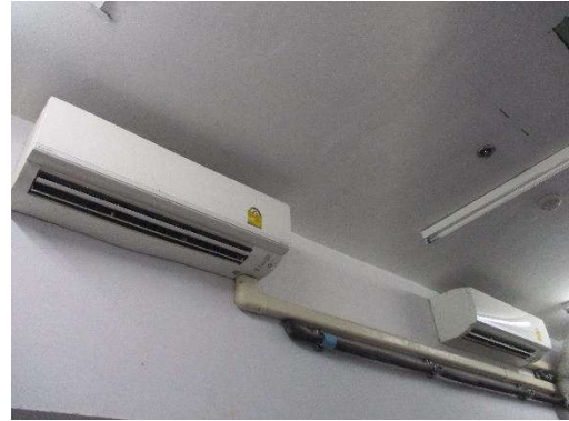
รูปที่ 35 ระบบระบายอากาศในห้องพักมูลฝอย
