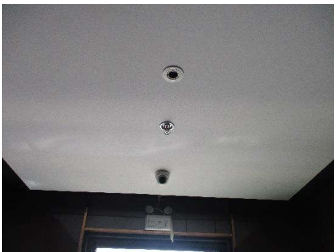
รูปที่ 46 หัวกระจายน้ำอัตโนมัติ (Sprinkler)
