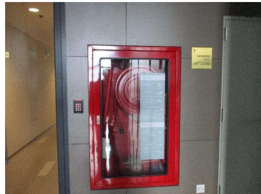
รูปที่ 44 ตู้เก็บสายฉีดน้ำดับเพลิงพร้อมอุปกรณ์และป้ายแนะนำการใช้งาน
