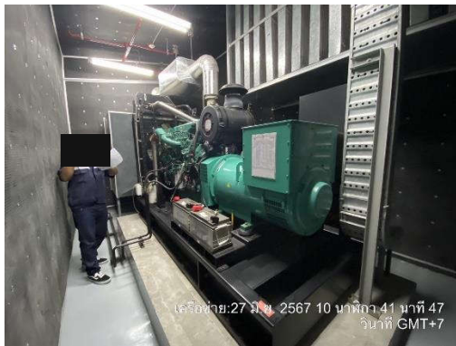
รูปที่ 36 เครื่องกำเนิดไฟฟ้าสำรอง
